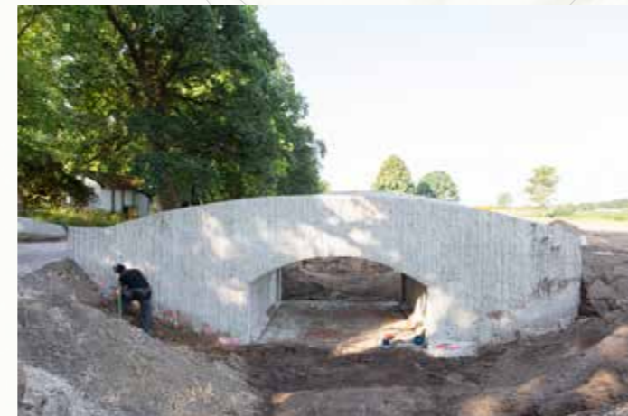
4 SEPTEMBER 2019 / 16:42 Aanleg van de vijver en bruggen
